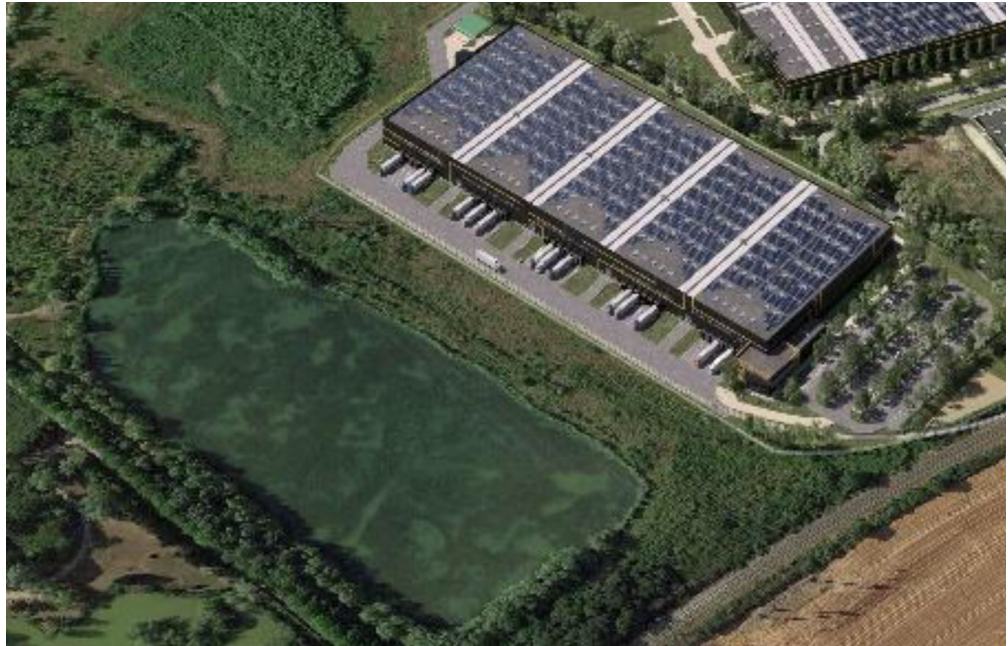
Zoom sur l'insertion paysagère qui montre la très grande proximité dans les faits entre les zones de déchargement et l'étang
